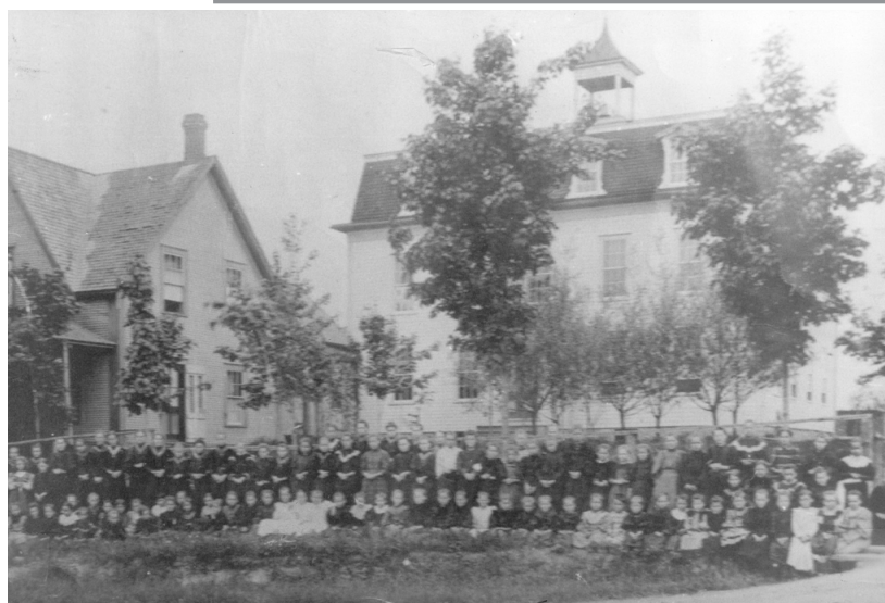
LA MAISON ST-JOSEPH (À GAUCHE) DÉMOLIE EN 1984, ET LE COUVENT DES FILLES DE LA CHARITÉ DU SACRÉ-CŒUR DE JÉSUS.
